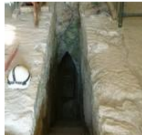
L'entrée du tunnel d'Eupalinos (en cours de restauration)
