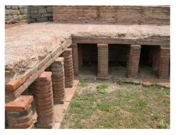
Les briques sont généralement carrées ou rondes. La hauteur des pilettes est de 40 à 60 cm, ce qui permet à l'air chaud de circuler sous tout le sol. Pour augmenter la température intérieure, la fumée des foyers et l'air chaud de l'hypocauste circulaient dans l'épaisseur des murs, avant d'être évacués par une cheminée.
